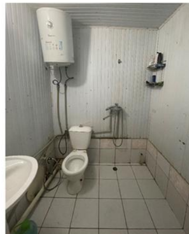
Ҳочатхонаҳо - нақби Туннел Садад Ориёно
