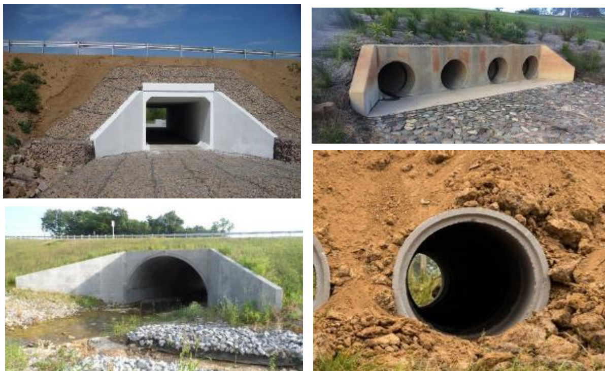
Рисунок 9. Типовые трубные и коробчатые водопропускные сооружения
