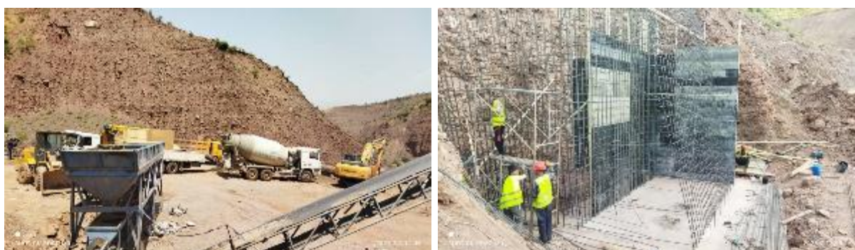
Рисунок 11. Текущее строительство, считающееся типичным для будущего строительства (опора моста справа)
